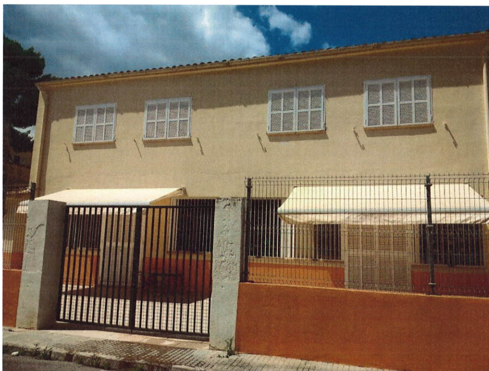
Fotografia 2. Façana del CEIP al carrer dels Germans Pinzón
