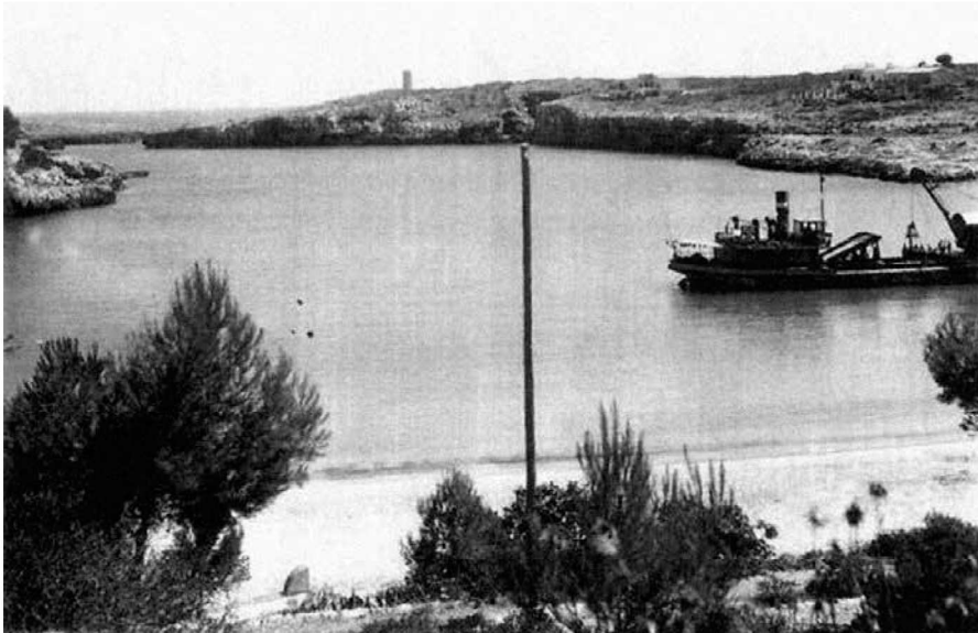
Fig.5. Fotografia de la bocana del port de Porto Cristo el 1936 durant els treballs de dragat. S'hi pot observar, precisament, la draga a l'àrea on després es construiria el "martell" o espigó que tanca el port (Riera Bordoi 2007, 128).
