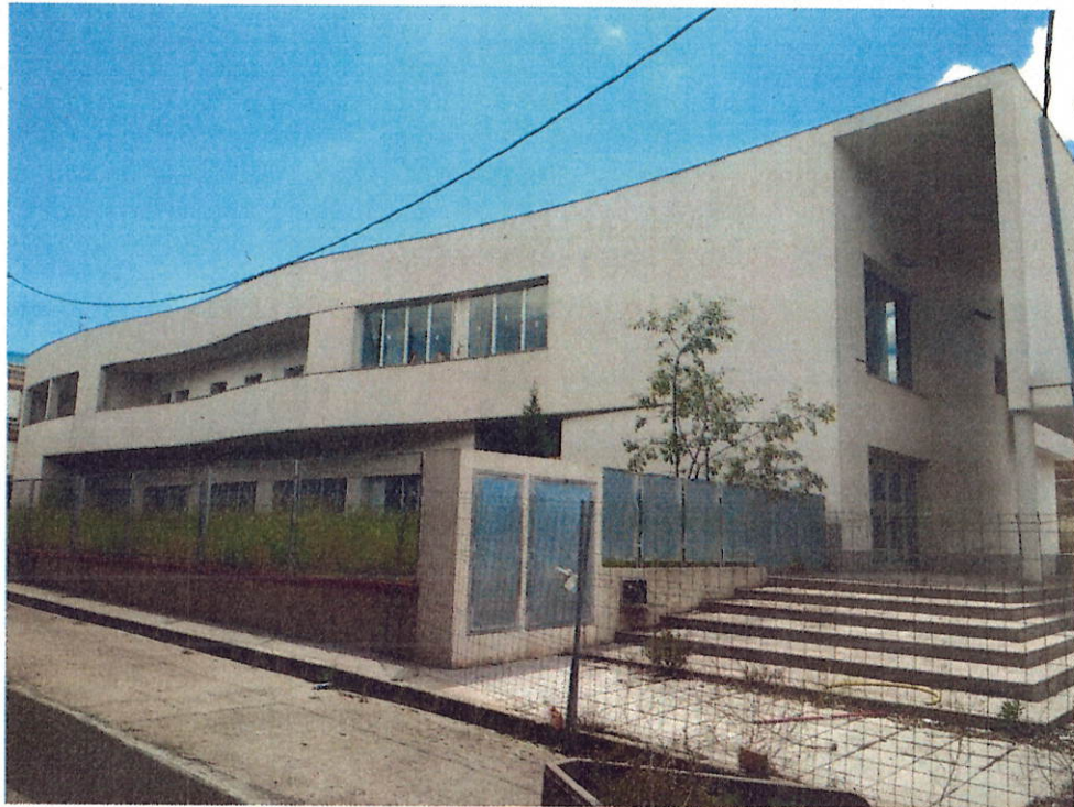
Fotografia 3. L'edifici que s'havia de destinar a equipament assistencial i que s'incorporarà al CEIP.
