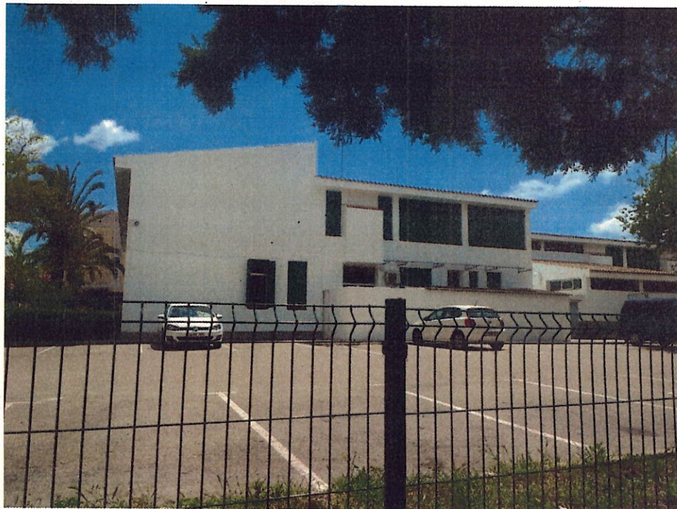
Fotografia 2. El CEIP i la seva zona d'aparcament, des del carrer Sebastià Nicolau Sureda.
